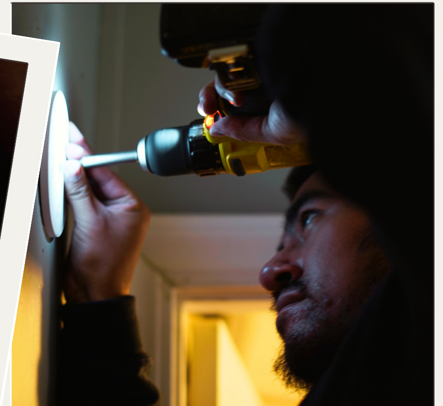
Final Inspection Inspección final
